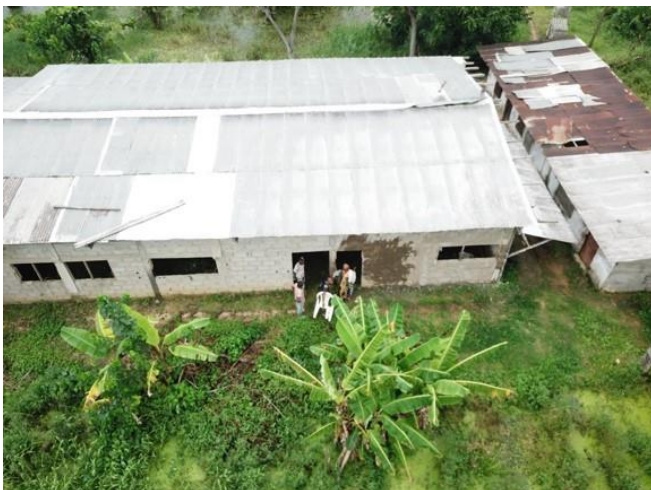
Der Umbau aus der Luft...
